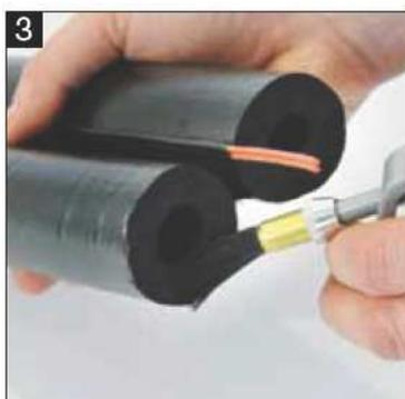
**3** Stirnseiten der Dämmung mit EPDM Kleber einstreichen.
