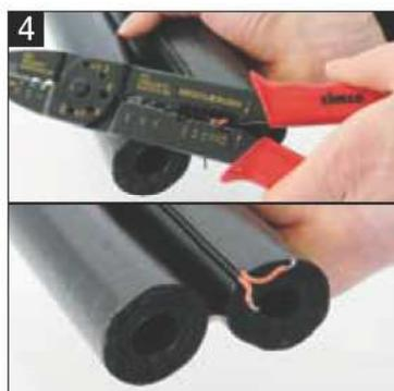
**4** Fühlerleitung abisolieren, 1cm
