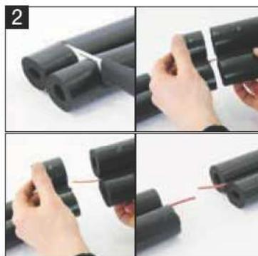
**2** Dämmung an jeder Stirnseite um mindestens 5 cm kürzen, damit das Kabel 5 cm frei liegt.
