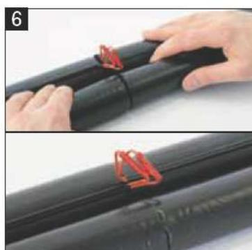
**6** Dämmung an den Klebefläche zusammenpressen. Darauf achten, dass die Kabel nicht mit verklebt werden.
