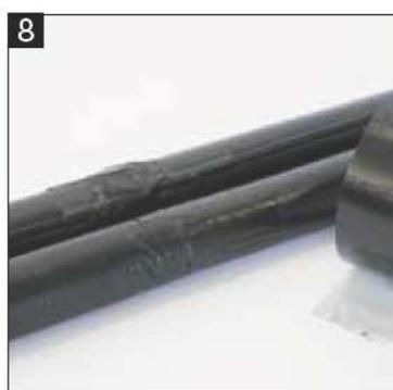
**8** Abkleben der Kontakte und der Verbindung mit schwarzem Gewebband.
